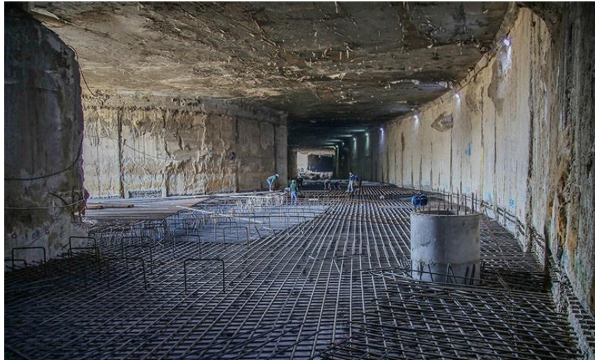
الشكل (12) الاعمال الانشائية في النفق.
